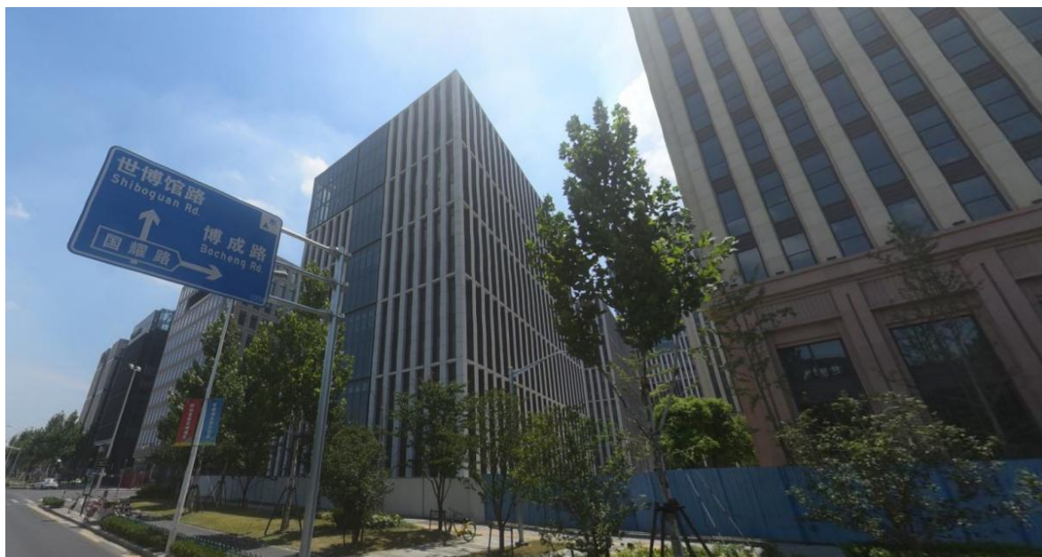
图二 三号楼西北侧
