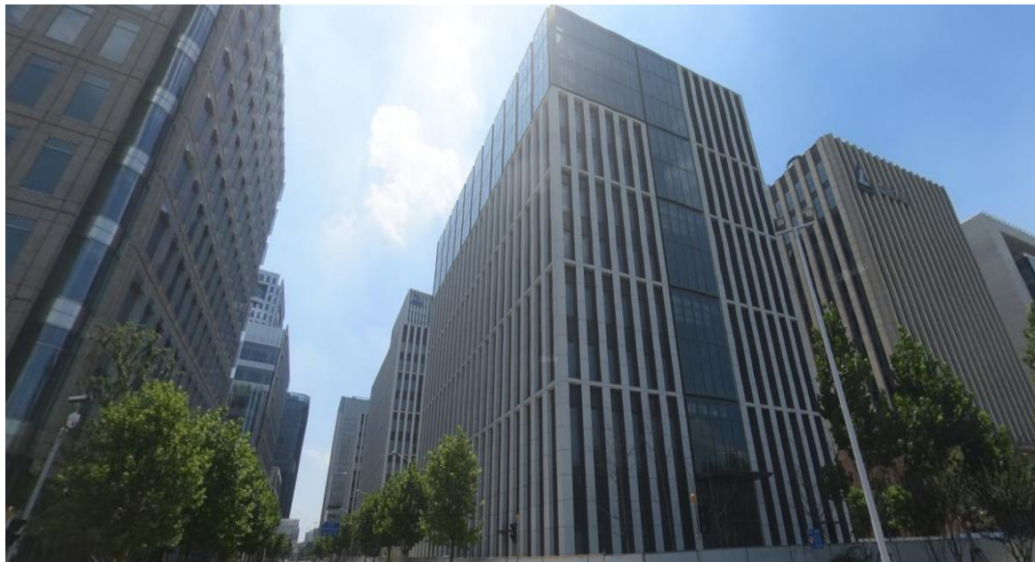
图一 三号楼北侧
